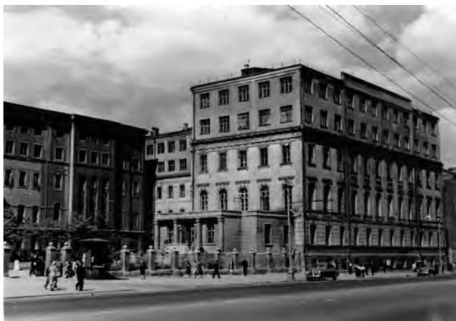
Рис. 1. Вид на здание московского института стали им. И. В. Сталина, конец 40-х – начало 50-х годов XX в.
