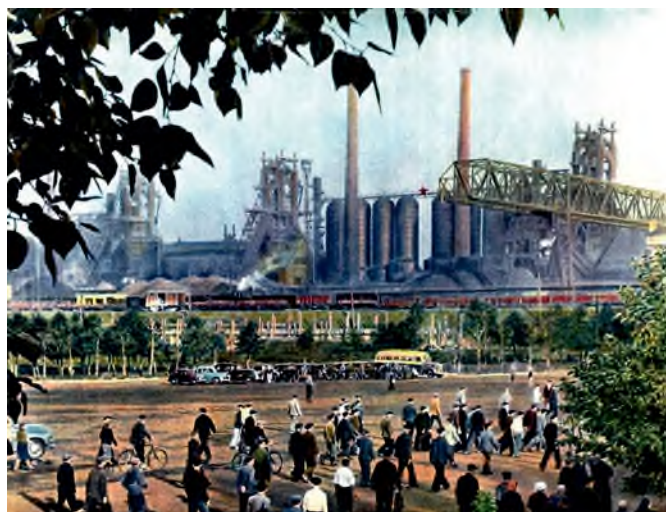
Рис. 3. Кузнецкий металлургический комбинат
